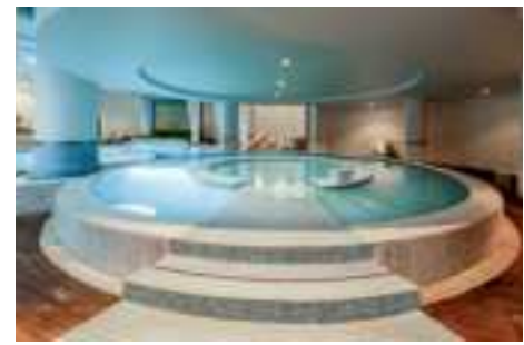
Крытый бассейн с джакузи
